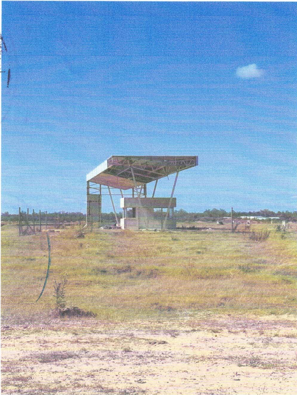
Figura 1. Edificio de acceso construido por antiguo desarrollador
