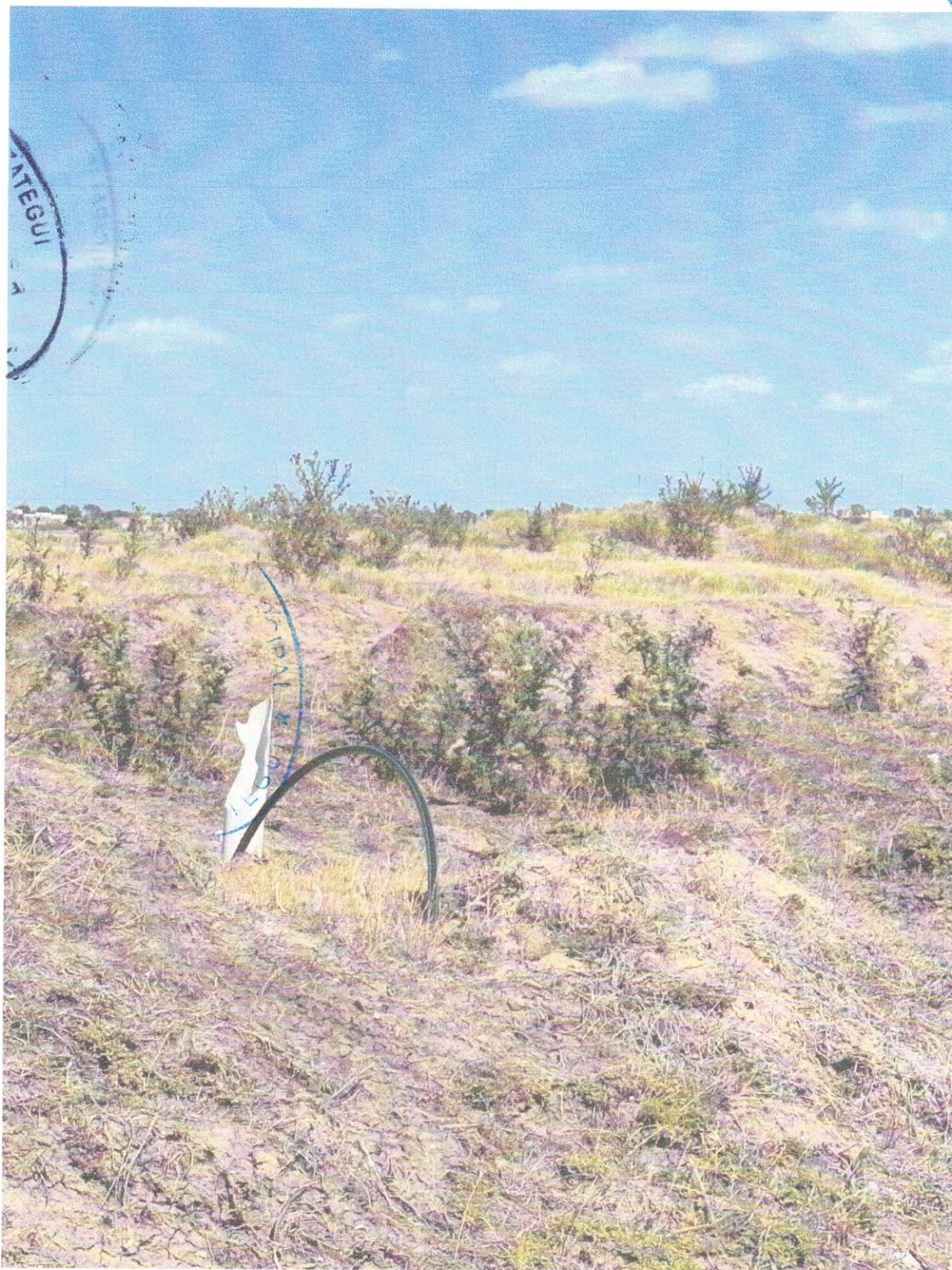
Figura 10. Tuberías rotas. Cables sueltos.
